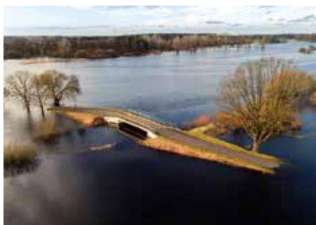
Die einsame Brücke, von Ostehochwasser umgeben, ist bei Mintenburg
